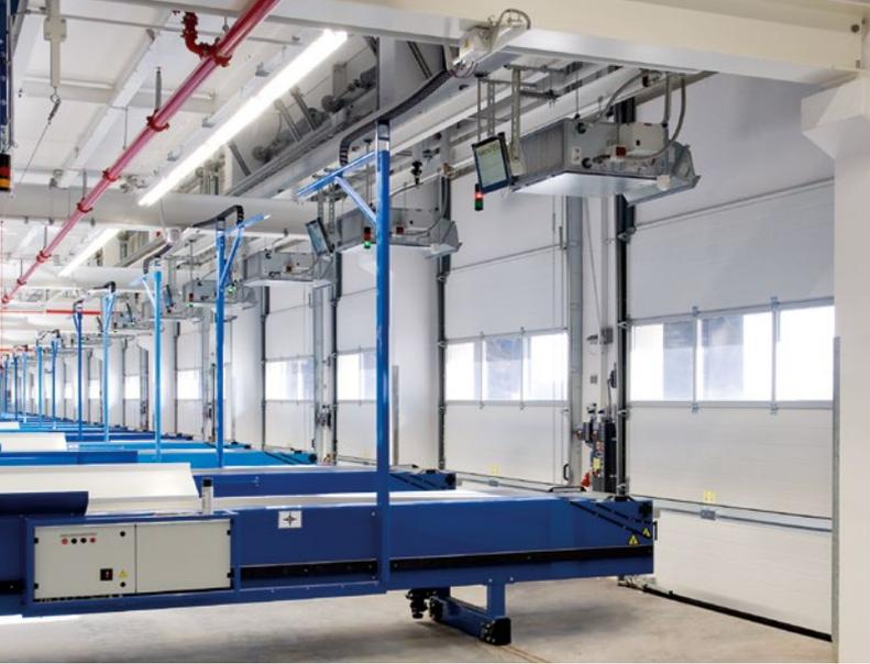
SUPERIOR IZQUIERDA. SPU F42 con buen aislamiento térmico para naves calefactadas
